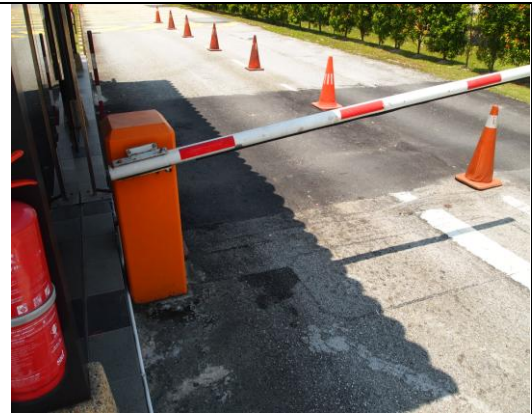
Foto 1.16: Penggunaan Boom Gate
