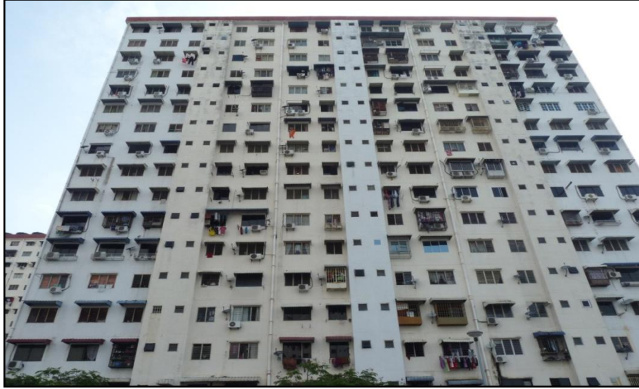
Rajah 5.4 : Blok Bangunan Pangsapuri Pelangi
