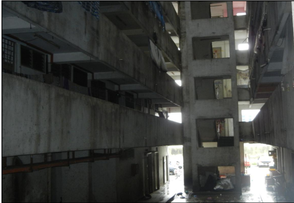
Rajah 5.9 : Keadaan Dalam Bangunan Flat Teluk Indah
