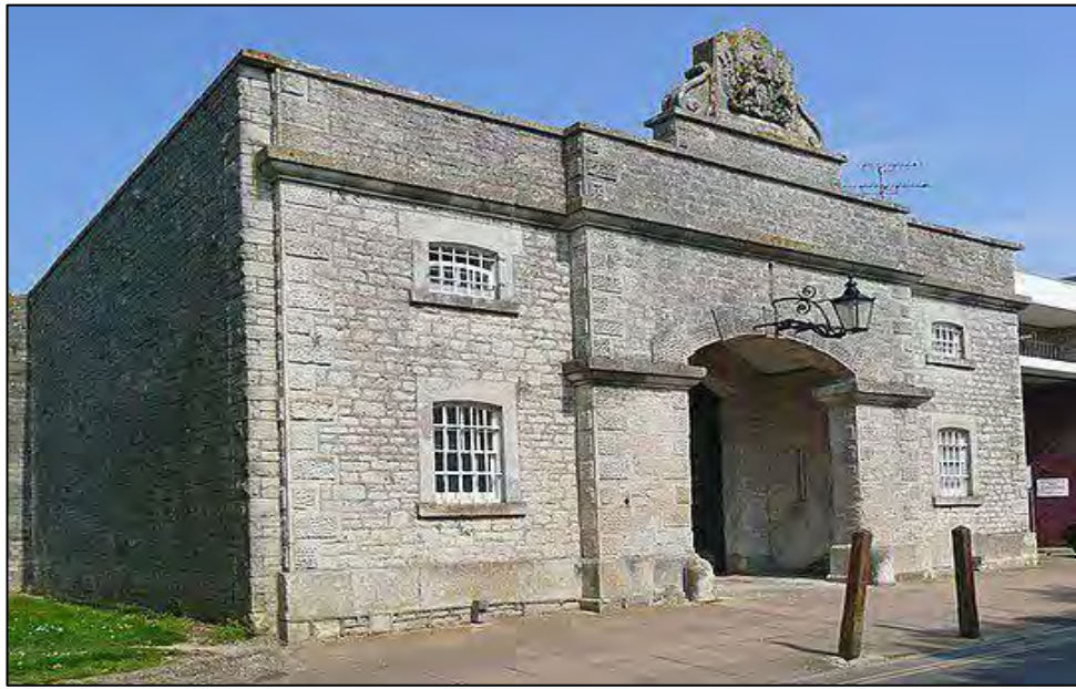
Rajah 2.4: Bangunan Penjara Borstal 126
